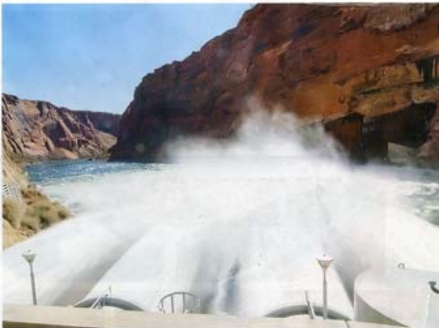
L'idroelettrico è la più antica delle energie pulite e rinnovabili: una specialità del Piemonte, che può contare su molti torrenti
